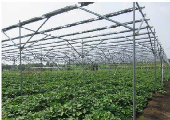
露地の畑の上部にパネルを設置
